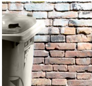
Ziegelmauerwerk Muratura di mattoni
