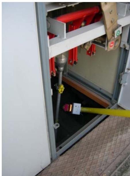
Abbildung 4.4: Magnetfeldsonde für den mobilen Einsatz
