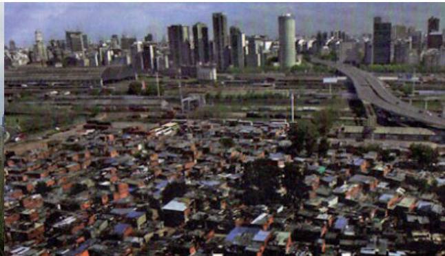
[118] Uferautobahn und Villa 31
