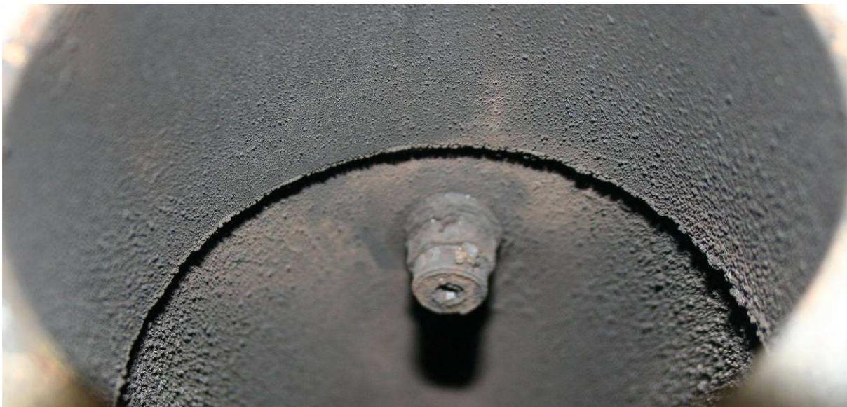
**Abbildung 7.22: Düse im Einbauzustand im Entspannungsbehälter**
