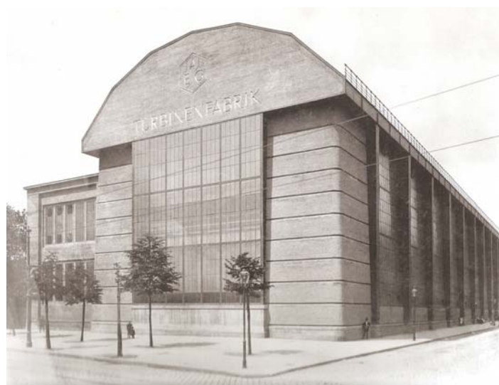
Abb. 26: Turbinenhalle AEG Adam/ Hausmann/ Jüttner 2004, 10.
