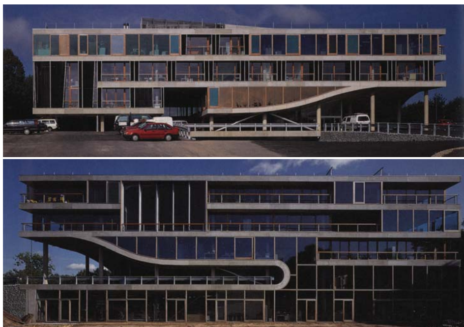
Abb. 77: Villa VPRO, Ansichten der fließenden Decken Van Assche 1997, 2464-1465.
