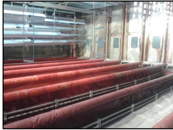
Abbildung 23: Quertaktanlage mit Warenträger
