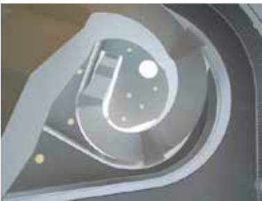
Abb. 19-20.: Haupttreppe windet sich über den viergeschossigen Luftraum
