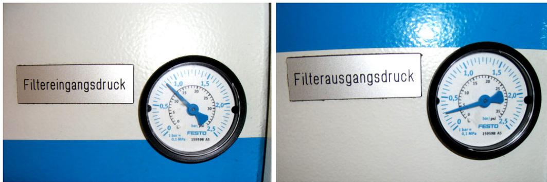
**Abb. 4.9** Vergleich Filtereingangs- zu Ausgangsdruck
