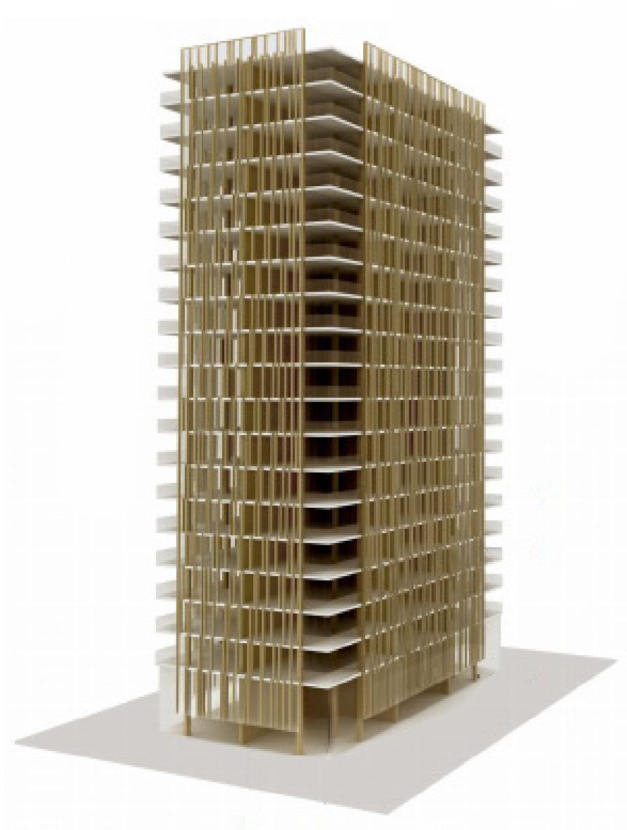
Darstellung eines 30-geschossigen FFTT-Designs mit lasttragenden Holzkern, Innen- und Außenwänden – Abb. 54
