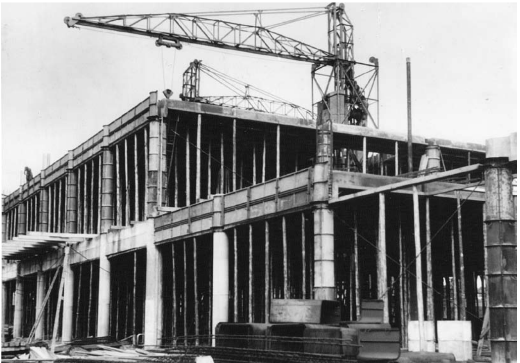
Abb. 56 Bau eines Fabriksgebäudes
