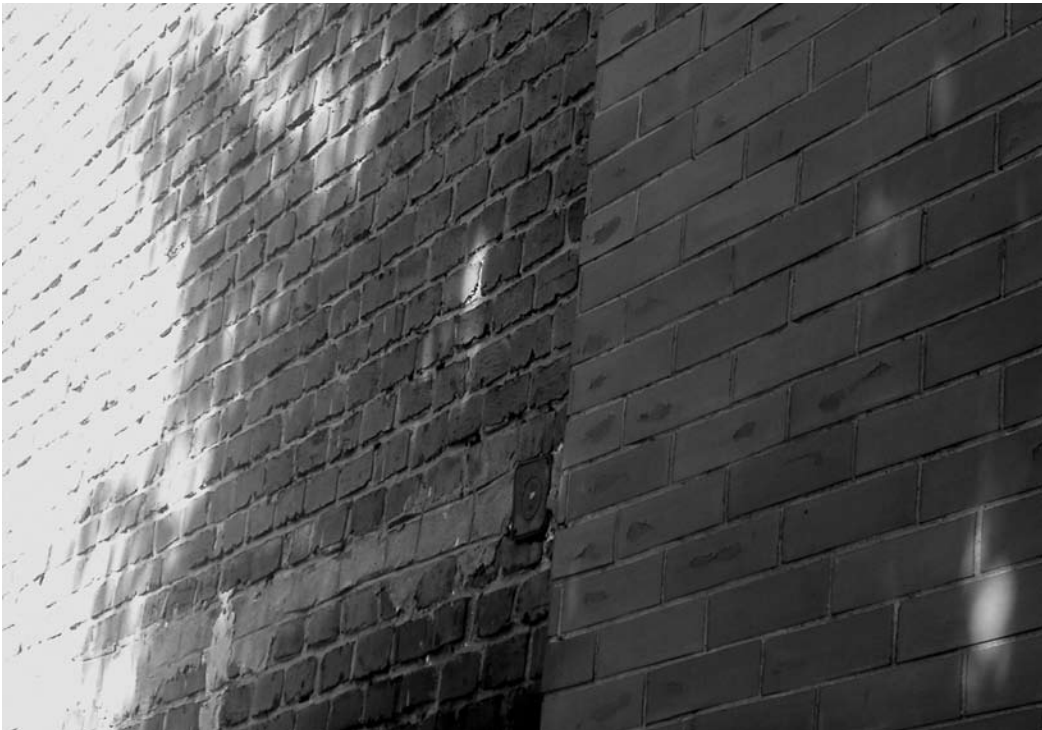
Abb. 8 Strukturunterschiede der Fassaden
