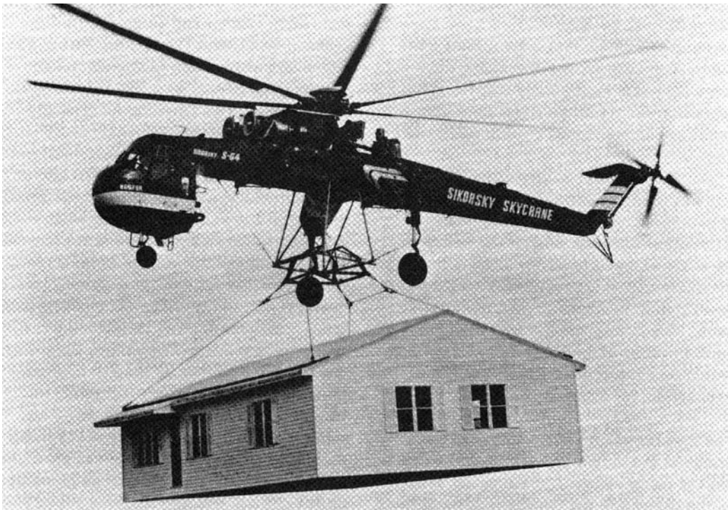
Abb. 64 Transport eines vorgefertigten Hauses aus den Siebzigerjahren
