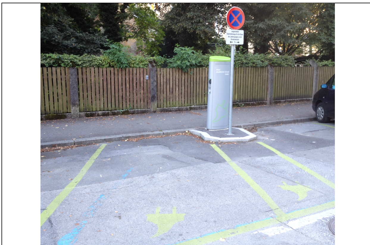
Abbildung 22: Öffentliche Ladestation mit Abstellplätzen 183
