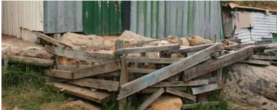
mit Steinen gefüllte Bretterschalung
