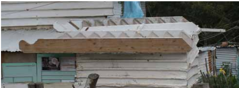
Dachauflast gegen Abheben des Wellblechs
