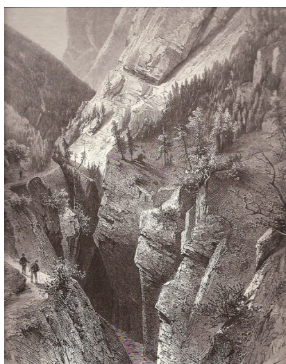
Abb. 20: die Bergwelt wurde gesichert. Im Bild die Strada d'Alemanga
