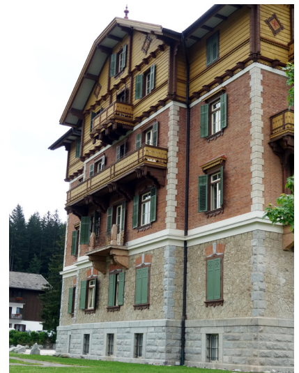
Abb. 76: Südbahnhotel Toblach, im heutigen und damaligen Erscheinungsbild
