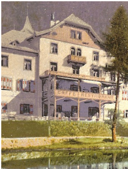
Abb. 97: Offener Verandazubau am Hotel Baur
