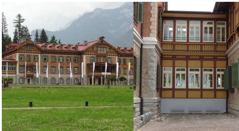
Abb. 13: Grand Hotel Toblach mit Verbindungsgang
