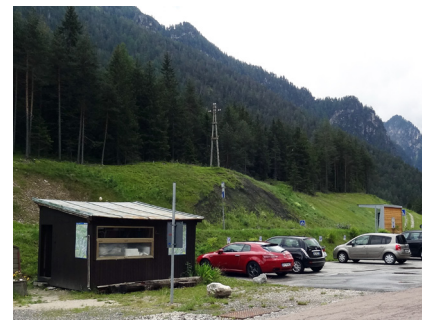
Abb. 35: (Rechts) Hotel Baur Liftanlage Abb. 36: (Oben) Antriebsanlage des Liftes
