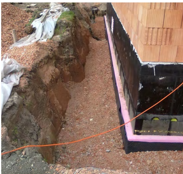
Abbildung 34: Hinterfüllung von Gebäuden mit Ziegelbruch (Quelle: https://brunmeir.wordpress.com/category/allgemein/page/8/ )
