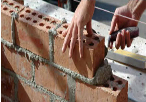
Abbildung 16: Mörtelverbindung (Quelle: http://www.haus-infos.net/bauen/mauern.php )
