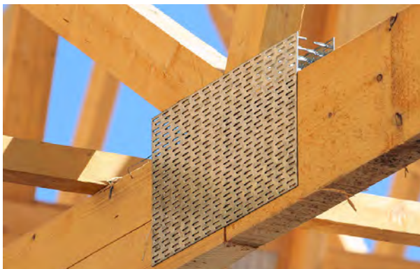
Abbildung 13: Nagelplattenverbindung (Quelle: http://www.payer.de/tropenarchitektur/troparch0452.htm )
