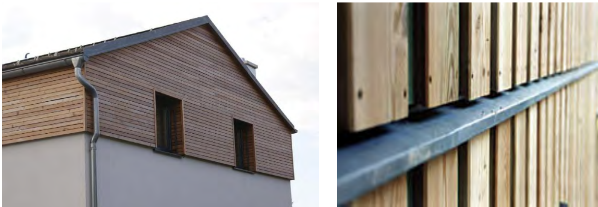
Abbildung 26: Holzfassade Haus Rainer, Graz
