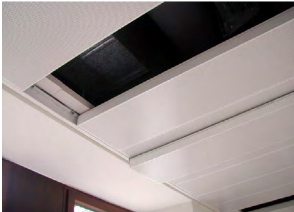
Abbildung 29: abgehängte Blechkassettendecke (Quelle: Fa. Armstrong)
