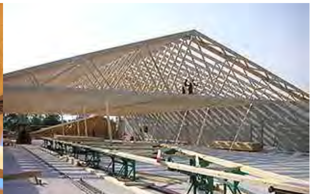
Abbildung 14: Nagelplattenbinder (Quelle: http://www.opitz-holzbau.de/s296/nagelplattenbinder/nagelplattenkonstruktionen.html )
