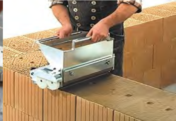
Abbildung 17: Dünnbettmörtelverbindung (Quelle: http://www.pro-casa-bau.de/index.php?46c5bc2a0a5d6 )
