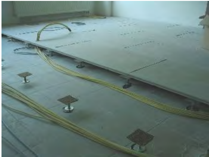
Abbildung 33: Doppelbodensystem (Quelle: Fa. Knauf)
