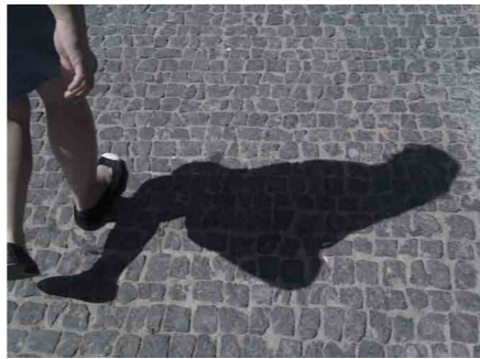
Abb 2. Kopfsteinpflaster im Zementgebundenen (Trasszement) Sandbett verlegt,
