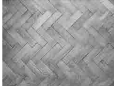
Abb 1. Eichenparkett teilweise Bestand geschliffen und versiegelt
