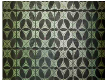
Abb 2. Keramikfliesen in den Sanitärbereichen
