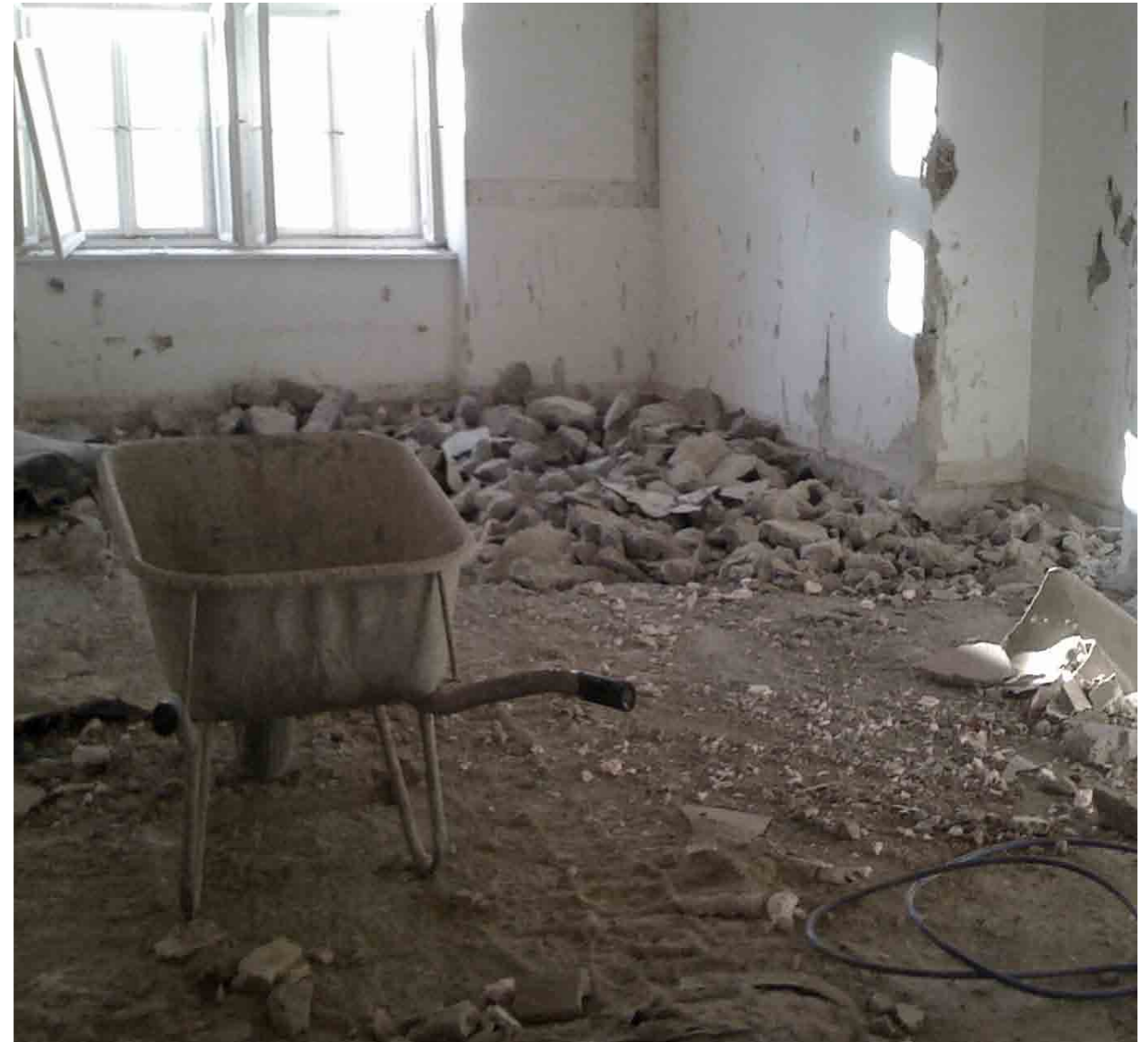
Abb.1 Baustellenszene Bauen im Bestand
