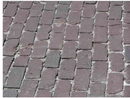
Abb 1 diffusionsoffener Boden Ziegelpflaster in Sandbett verlegt
