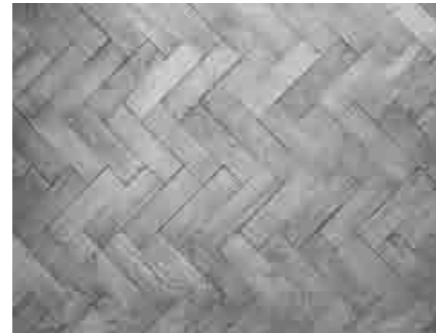
Abb 1. Eichenparkett teilweise Bestand geschliffen und versiegelt
