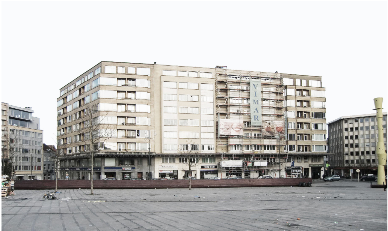
Abb.19: Bestandsgebäude, Blick von Place Flagey
