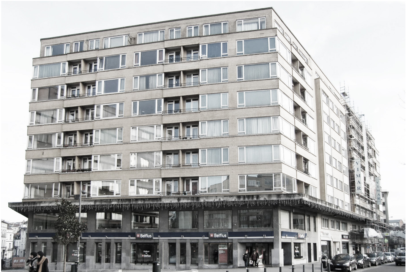
Abb.25: Bestandsgebäude, Blick von Place Flagey
