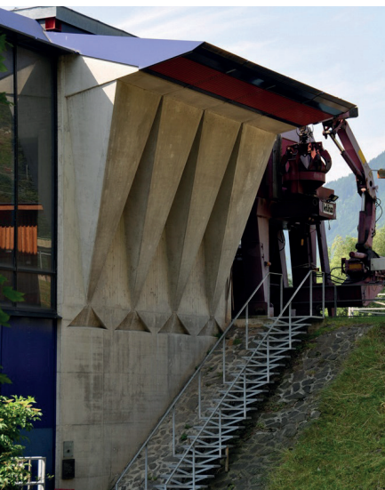
Abb. 5.30 Lüftungspyramiden an der Nordfassade des Maschinenhauses
