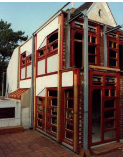
Abb. 5.04 Südwestansicht des Stahl-Skelett-Zubaus
