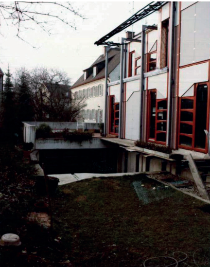
Abb. 5.18 Ansicht von Südosten, Geländemodellierung: Ausgang vom Kellergerüst in den Garten
