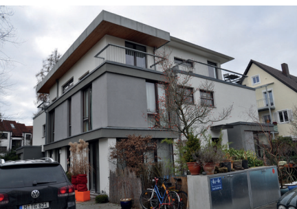
Abb. 5.19 Nordwestansicht des Gebäudes in der Anna-Dandler-Straße 2013
