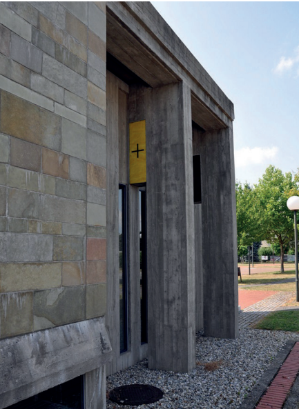
Abb. 5.51 seitliche Betonmauern der Kapelle
