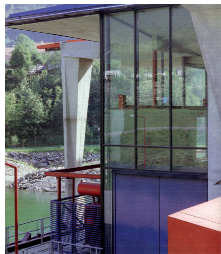
Abb. 5.33 Nordansicht des Maschinenhauses mit großer Glasfront
