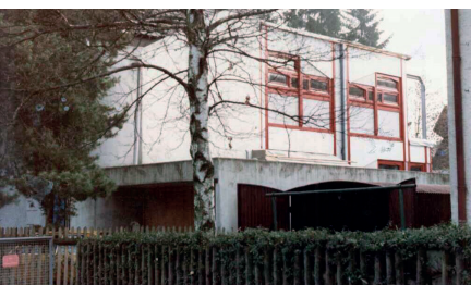
Abb. 5.05 Straßenseitige Nordansicht mit kleinen Fassadenöffnungen
