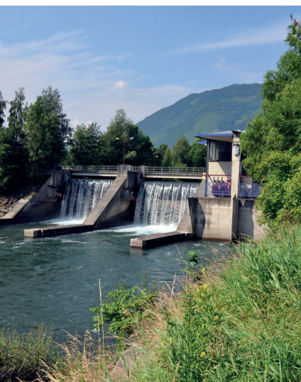
Abb. 5.24 Nordansicht Kraftwerk mit Wehr und auslaufenden Pfeilern
