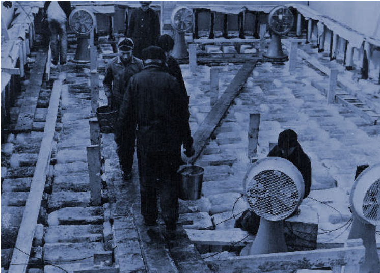
Bau des Pykrete-Testmodells Habbakuk am Patricia Lake, Kanada, 1943
