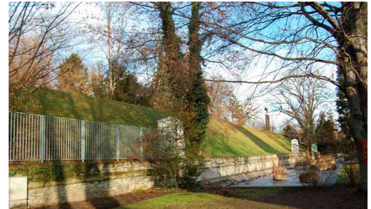
POSITION 1: Anfangspunkt der Böschung im Bereich des Cafes Promenade von Ebene Stadtpark aus betrachtet.
