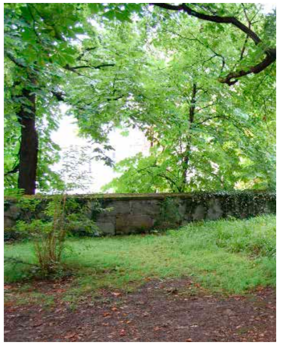
POSITION 2: Brüstung im südlichen Teil des Burggartens.
