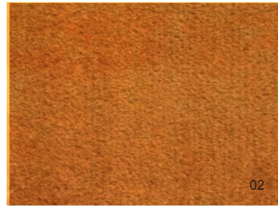
Abb. 149 Besenstrich behandelte Oberfläche.
