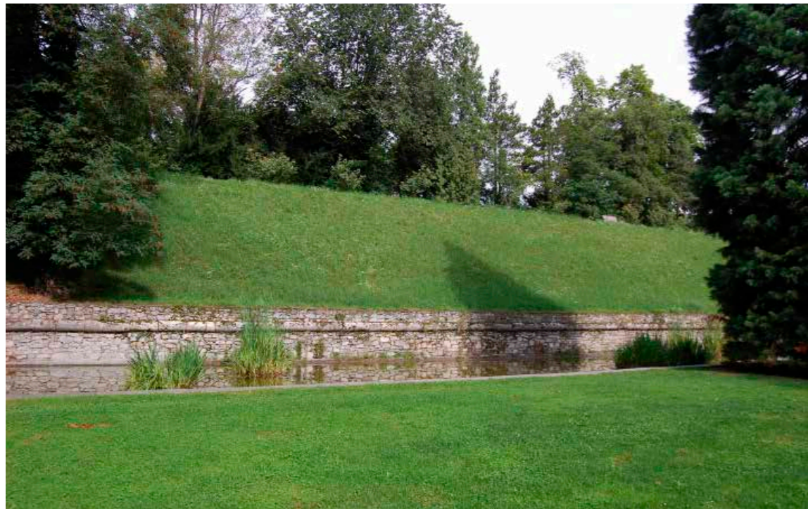
Blick vom Stadtparkniveau aus auf den Burggarten hinauf.
