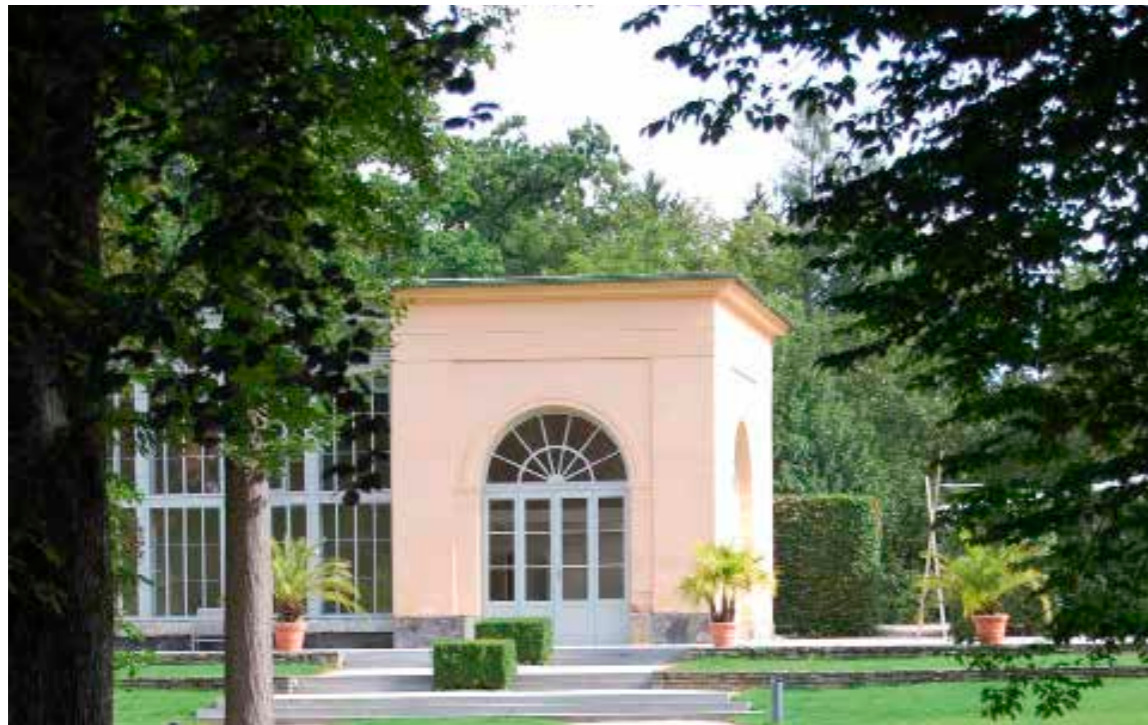
Blick nach Norden auf die Orangerie.
