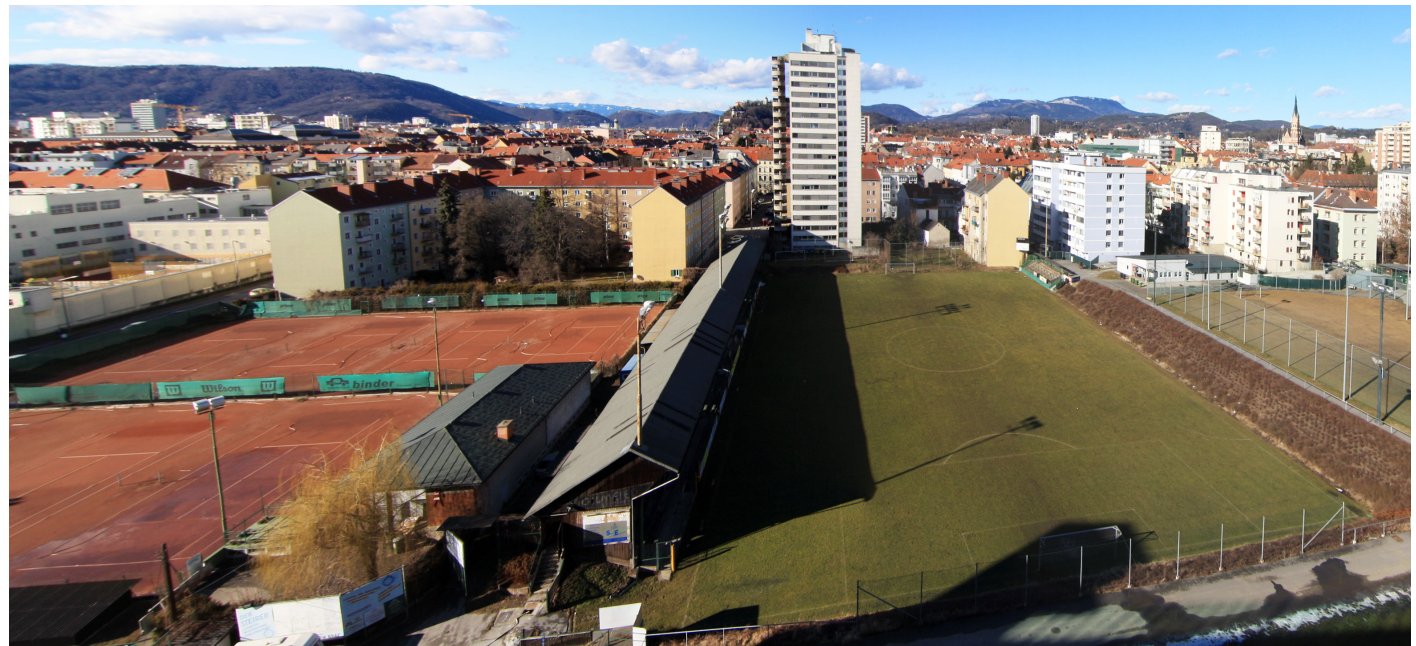
Abb. 42 Bauplatz in Richtung Uhrturm
