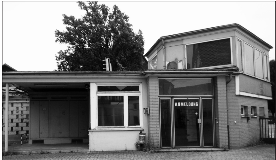
Abb. 66 oben: Hofseitige Fassade der Fahrzeughalle, re. 1. Bauabschnitt 1967, li. 2. Fertigstellung 1975 (2012) Abb. 67 unten: Meldezentrale 1974 (2012)
