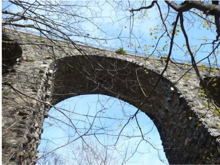
Die Viadukte der Erzbergbahn bestehen aus abgeglichenem Quadermauerwerk, vermutlich mit Bruchsteinhinterfüllung.<sup>12</sup> Nach vollendeter Hintermauerung der Gewölbe blieben die Lehrgerüste vier bis sechs Wochen versetzt, um eine Senkung der Gewölbescheitel zu verhindern.<sup>13</sup>
