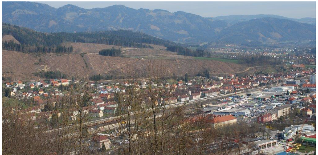
Abb.29 Blick auf die Hochschwabsiedlung
