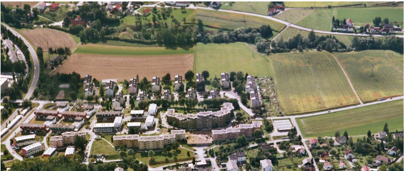
Abb.51 Schrägaufnahme Wohnsiedlungen Hermann Löns Straße und Johann Josef Fux Straße
