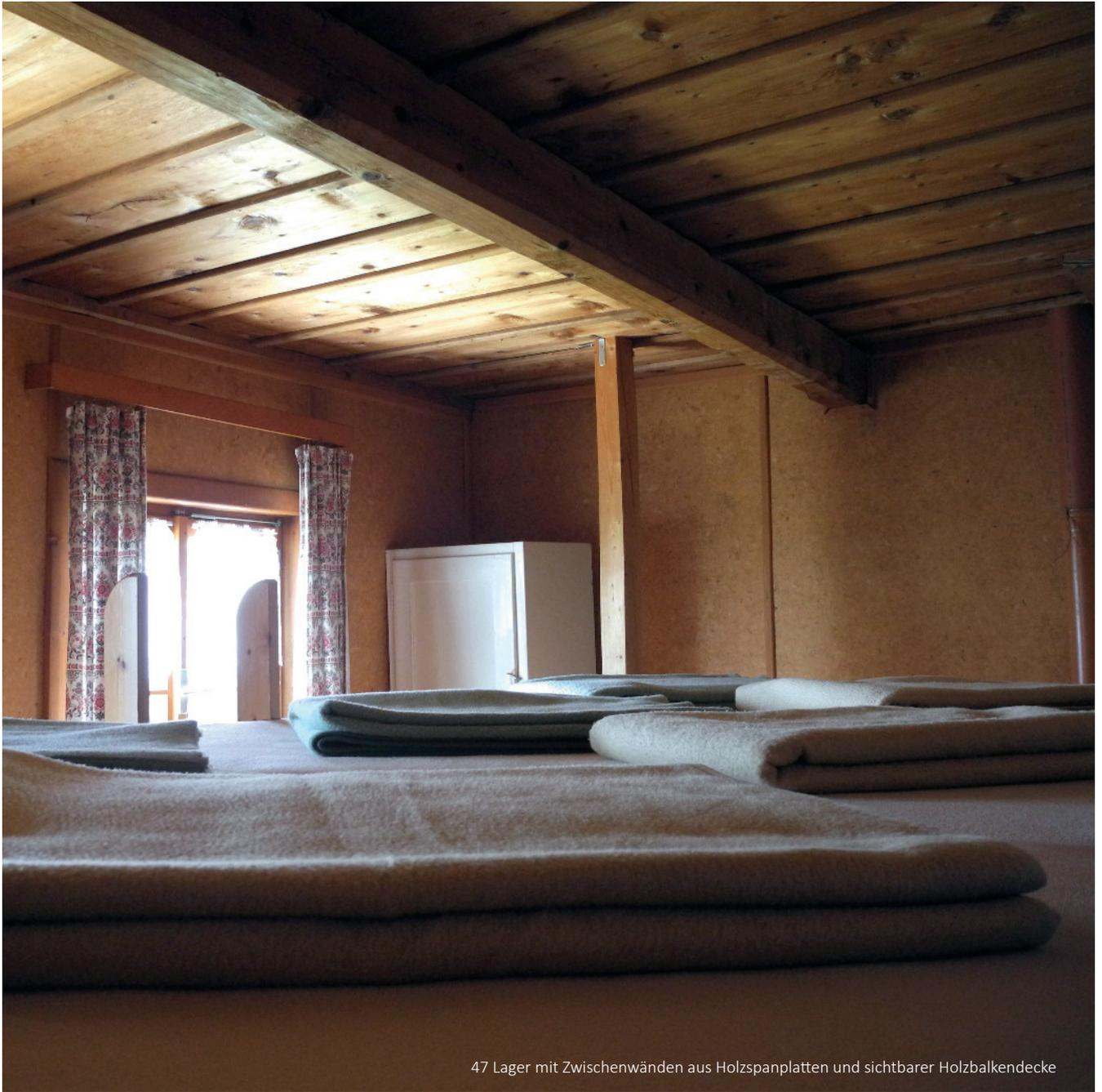
47 Lager mit Zwischenwänden aus Holzspanplatten und sichtbarer Holzbalkendecke
