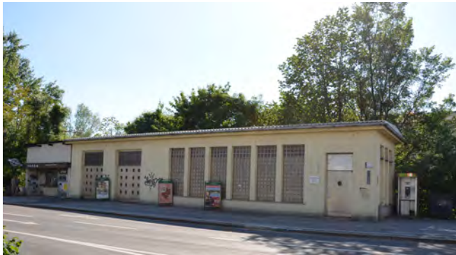
Abb47: Trafogebäude mit leerstehender Trafik
