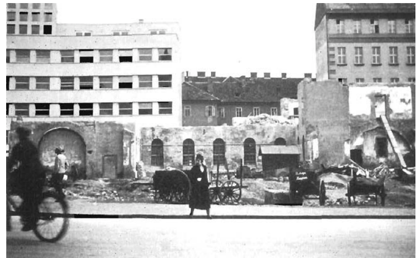
Abb.8: Abbruch der Kirche und noch bestehender Klosterfeile um 1934
