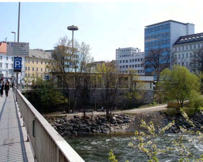
Abb.49: Blick von Tegetthoffbrücke im Frühling
