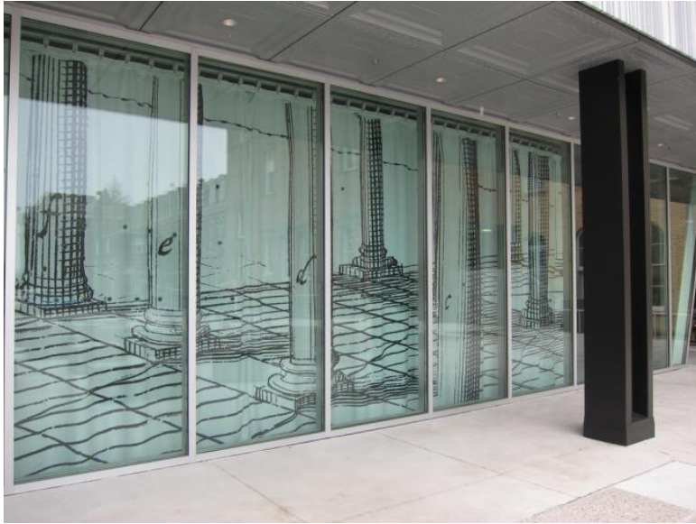
Abb.61 Außenansicht der Hörsaalfassade
