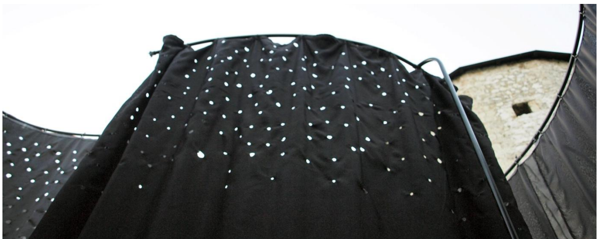
Abb.223 Außenschale des Pavillon-Kerns
