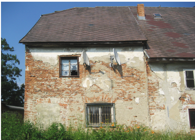
NEUDORFER MÜHLE Westen und Norden 2013 ABB. 49 ABB. 50
