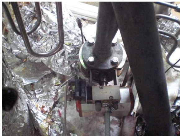
Abbildung 5-3: pneumatisch betätigter Kugelhahn
