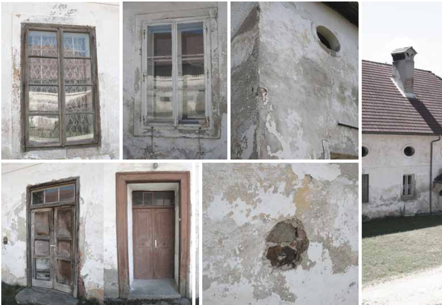
Abb.29. Fenster und Türen
