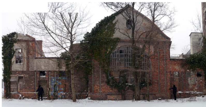
29 Westfassade Gebäudebereich B (B3 + B4)
