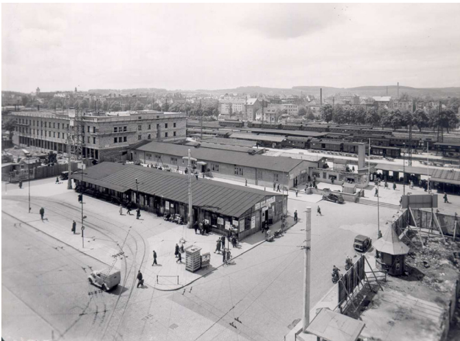
Abb. 2-24: Bahnhof und Bundesbahnhotel 1950
