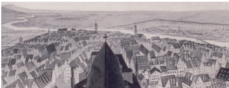
Abb. 2-33: Brückenkopf südlich der Donau
