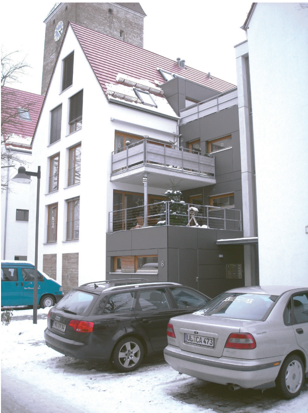
Abb. 1-13: Wohnhaus im Viertel Neustadt
