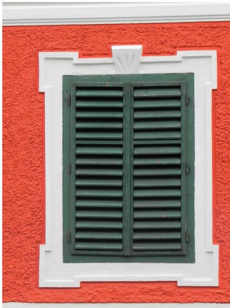
Abb. 199: Fenster Erdgeschoss mit Holzfensterladen
