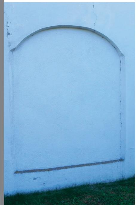
Abb. 133: Detailansicht vermauertes Tor im Westen
