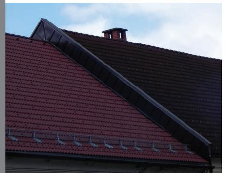
Abb. 270: Dachansicht und Übergang zum Nachbargebäude durch eine Feuermauer
