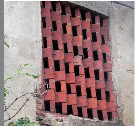
Abb. 250: Ziegelgitter an der Rückseite
