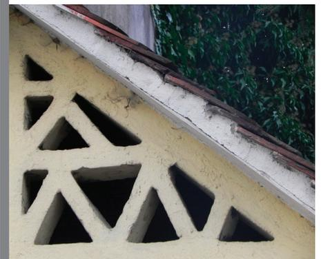
Abb. 170: Ziegelgitter - Detailaufnahme
