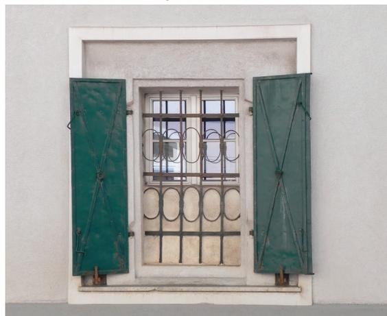
Abb. 82: Detailansicht Fenster mit Vergitterung und schmiedeeisernen Fensterläden
