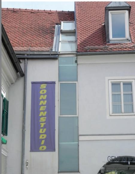
Abb. 76: Fensterelement, welches die ehemaligen zwei Gebäude optisch verbindet
