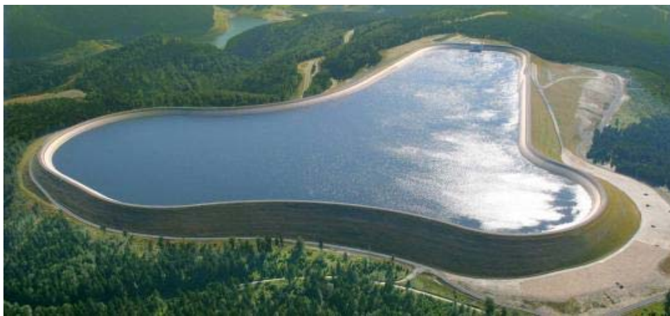
Abbildung 2.7: Oberbecken des Pumpspeicherkraftwerkes Goldisthal (Vattenfall Europe AG, 2012)
