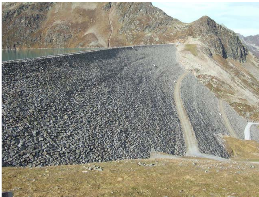
Abbildung 2.4: Schüttdamm des Speichers Finstertal der Kraftwerksgruppe Sellrain-Silz (Volz, 2012)
