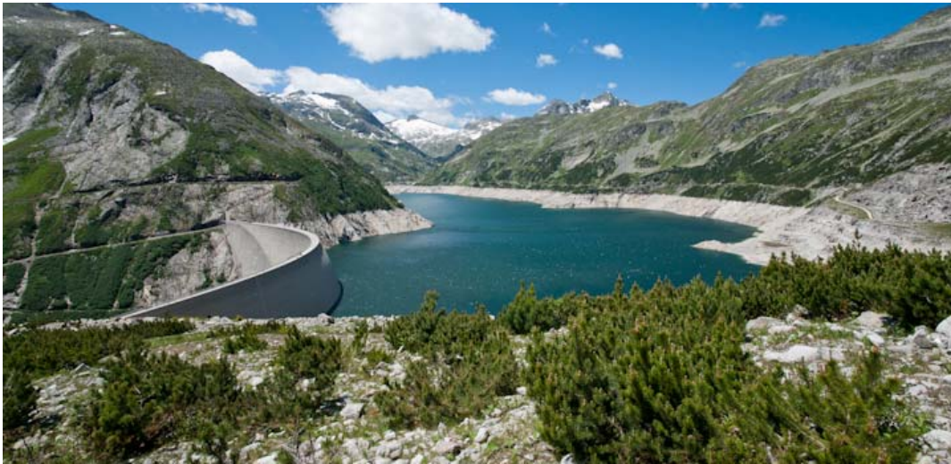
Abbildung 2.5: Bogenstaumauer der Kölnbreinsperre (Verbund, 2012)
