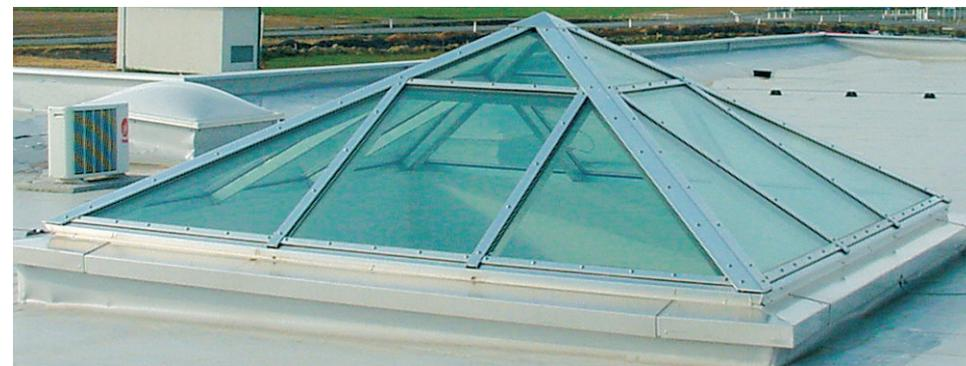
Abb. 190: Detail 5 und Beispiel einer Glaspypamide **M 1:20**
