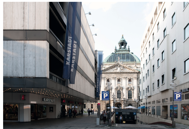
Abb. 15: Bauplatzrundgang Position D
