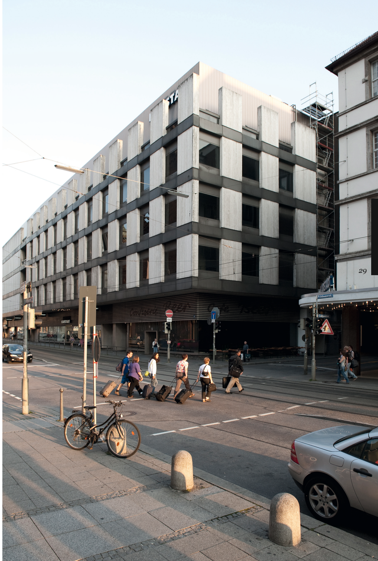
Abb. 19: Bau- platzrundgang Position H
