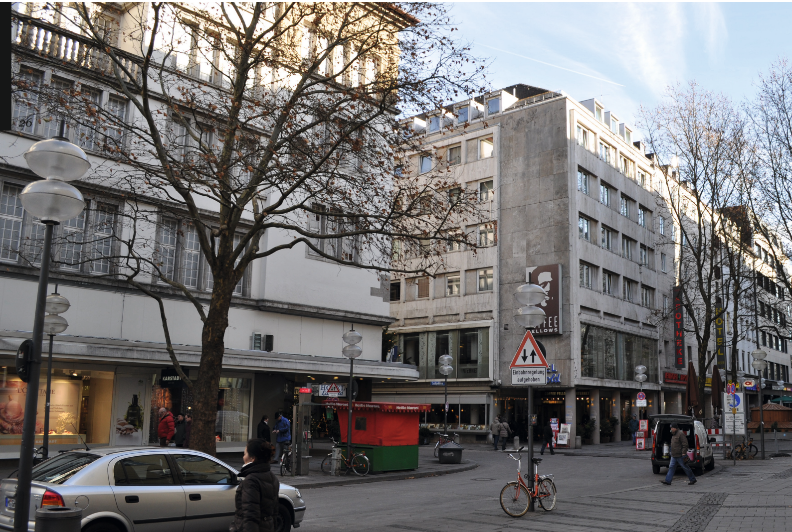
Abb. 12: Bauplatzrundgang, Position A
