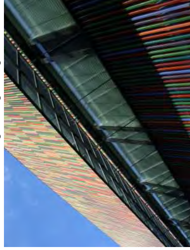
Abb. 94 | ausgeklappte Lichtlenkelemente – für die natürliche Belichtung der Erdgeschoßgalerien
