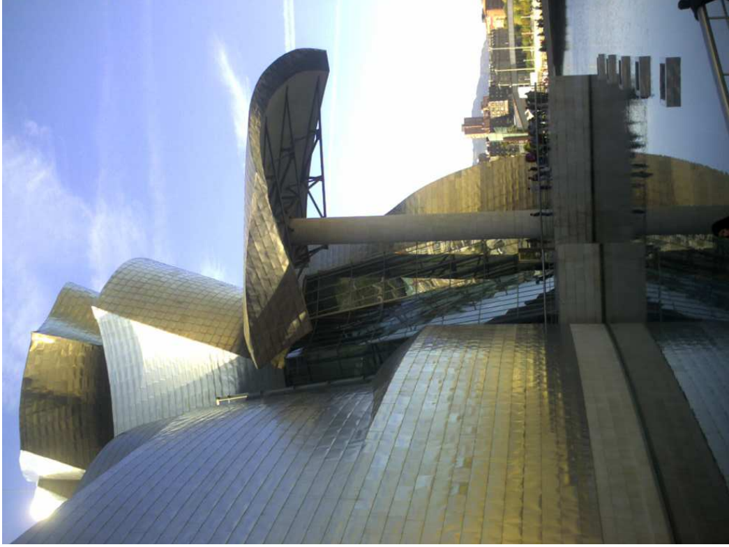
Abb. 65 | Titanzinkfassade und verglastes Atrium – zudem sieht man die mittels Balda- chin übertachte Terrasse
