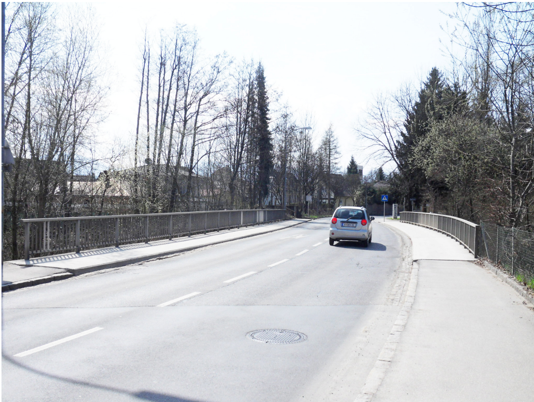
Abbildung 20 Grete-Bittner-Straße, Blickrichtung Süden
