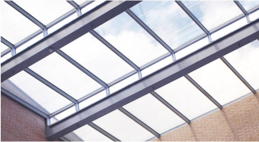
Abbildung 33: Beispiel für eine Photovoltaik-Verglasung mit 20% Transparenz 52
