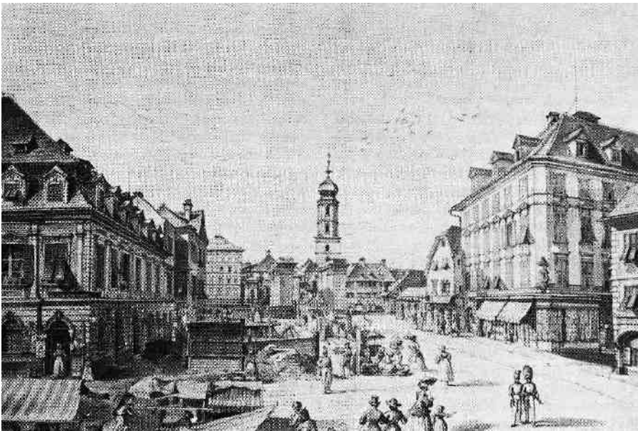
Abbildung 3: Südtiroler Platz, Baubeginn "Eisernes Haus" 1874, Bundesdenkmalamt 1983, 408
