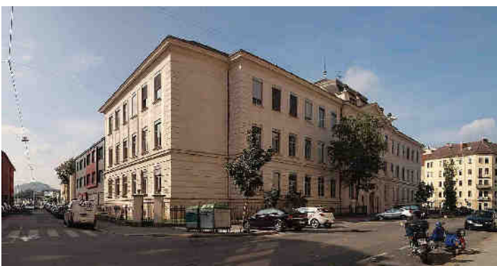
Abbildung 17: Ansicht Ecke Custozza- Oeverseegasse 2011
