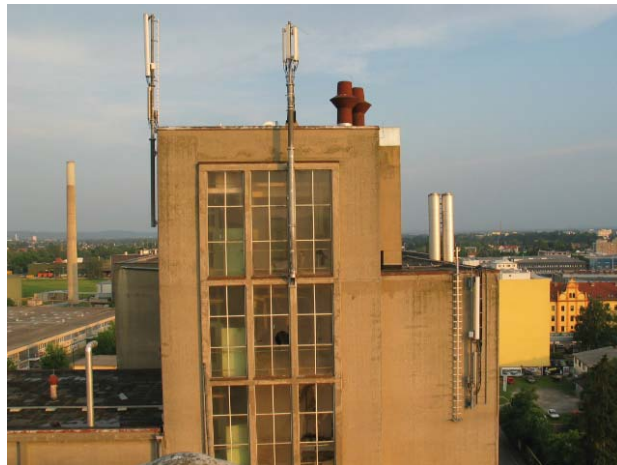
Blick auf den südlichen Silo
