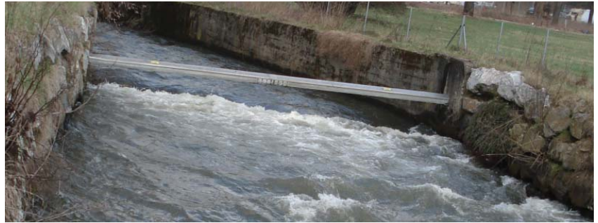
Mühlgang heute auf Höhe Fernheizkraftwerk
