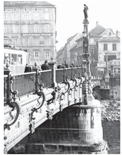
Eisenkonstruktion der alten Hauptbrücke
