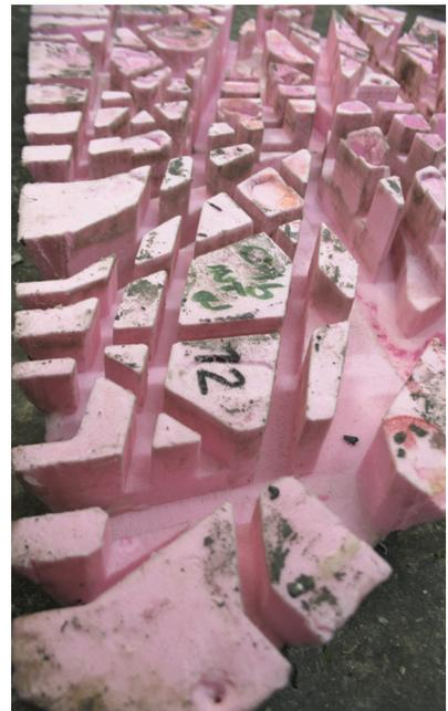
Segmentweise konnten nun die XPS-Teile vom UHPC durch Klopfen gelöst werden. Diese Arbeit musste sehr rasch erfolgen, da bei zu starkem Abkühlen das Wachs wieder erstarrt und das Ausschalen erschwert wird. Bei optimalen Bedingungen konnten die XPS-Schalungen schadlos entfernt werden und blieben somit wiederverwendbar.
