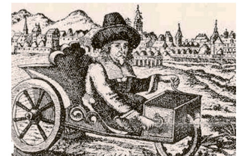
4 handbetriebener Vorläufer des Rollstuhls
