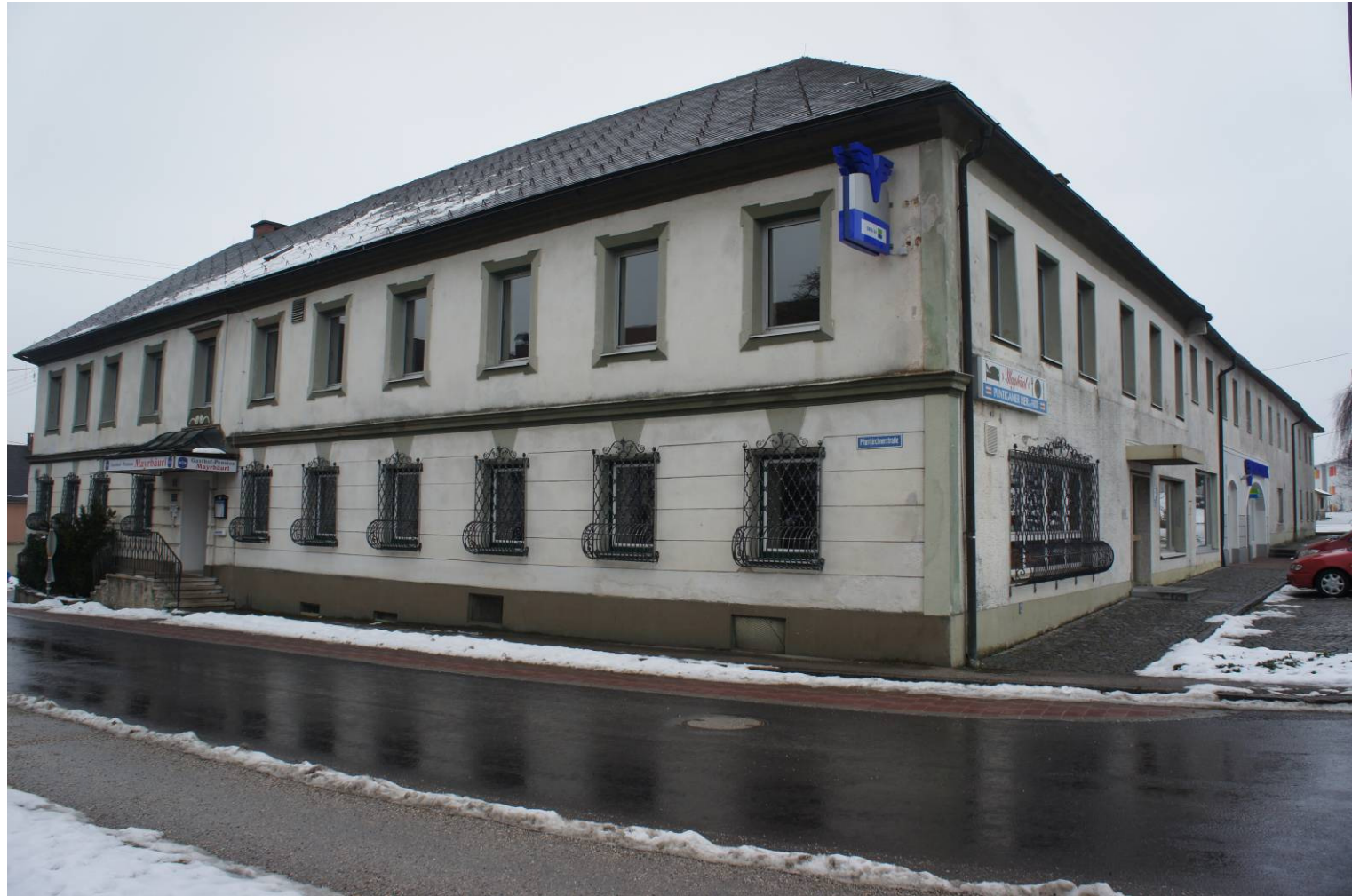
Abb.13: Im Moment befindet sich in dem Vierkanter unter anderem ein Gasthaus mit Pension. Das Gebäude ist im unmittelbaren Zentrum angesiedelt und bietet deshalb enormes Potential. Bild von 2013. 275
