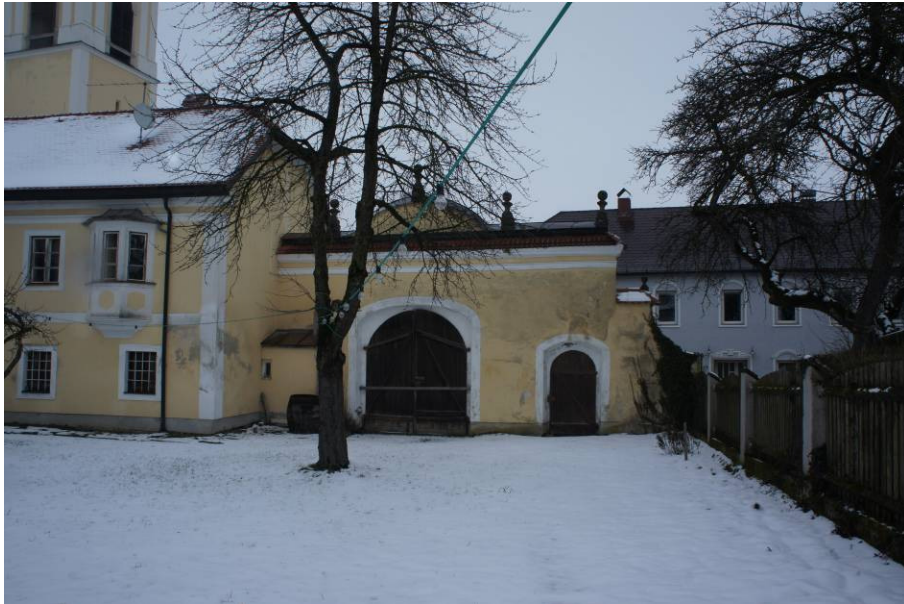
Abb.13: Pfarrhofmauer im Winter. Bild von 2013. 144
