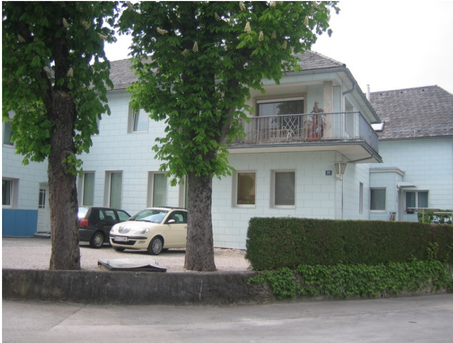
Abb. 14: Ansicht der ehem. Badeanstalt, 2007. 67
