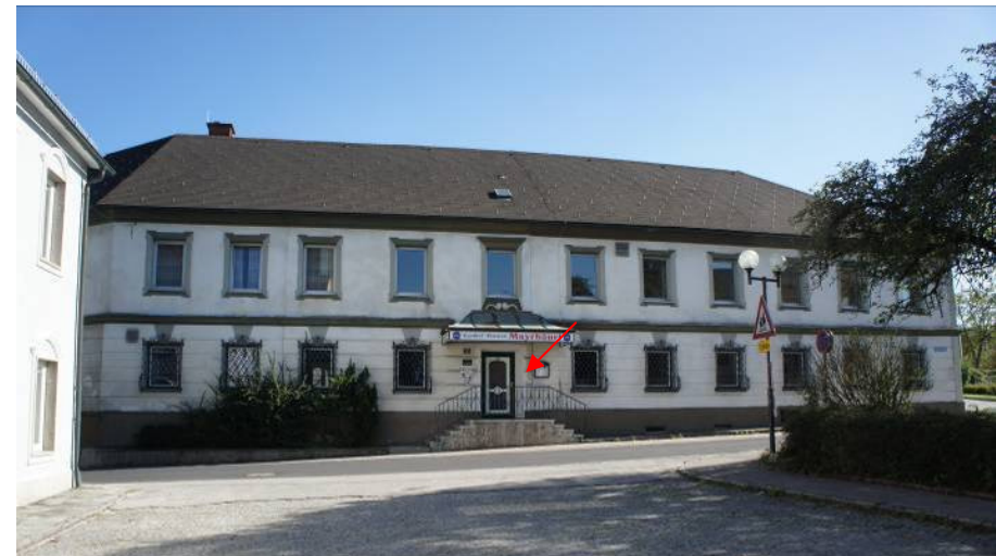
Abb.22a: Zugang zum bestehenden Gasthaus. 279
