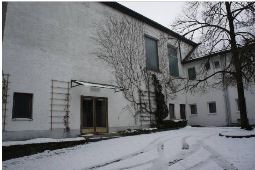
Abb.28: Links: Außenfassade des Kinos. Rechts: Zugang zum Kino durch den Innenhof. 285
