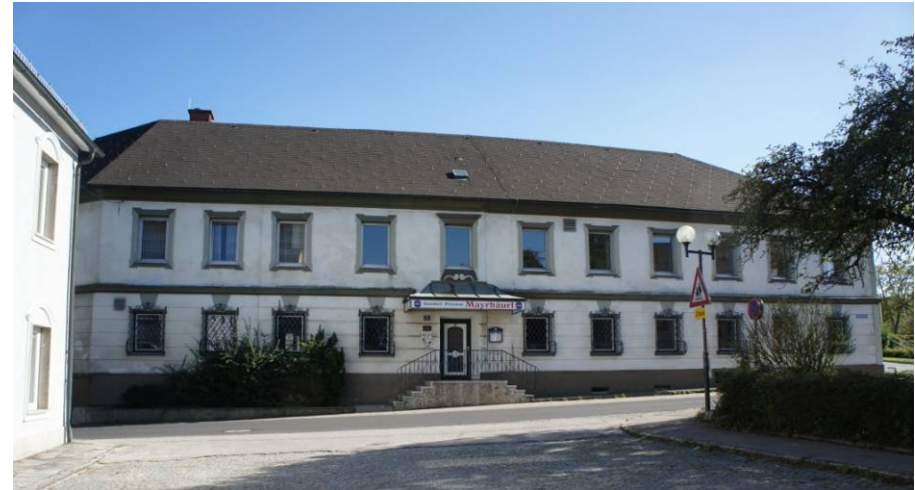
Abb.08: Nordfassade. Eingang zum Gasthaus. Bild von 2012. 269
