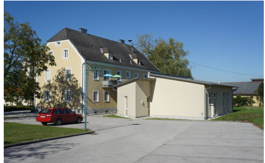
Abb.28: Der Gemeindezubau wurde 2003 fertiggestellt. Bild von 2012. 170
