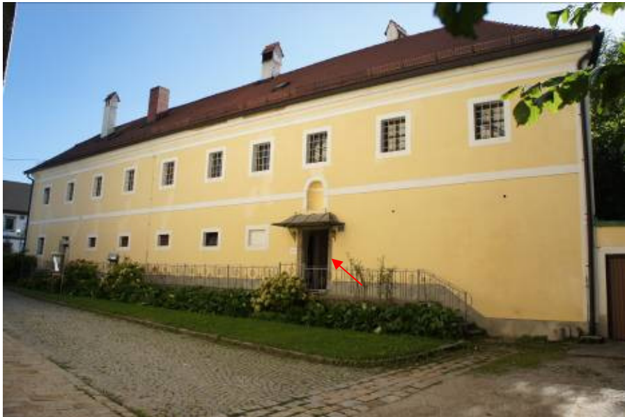
Abb.64: Der Durchgang zwischen Kirchenplatz und Pfarrhofsgarten wird geöffnet. Blick vom Kirchenplatz aus. Bild von 2012. 329
