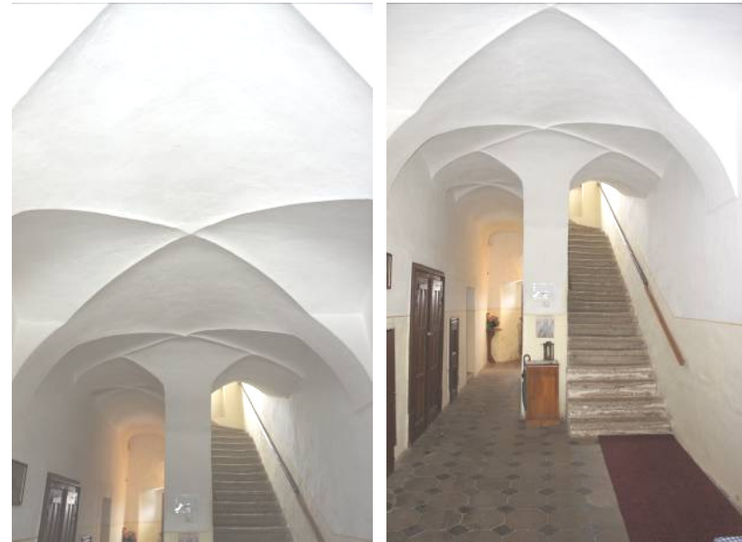
Abb.17: Mittelgang im Erdgeschoss. 312
