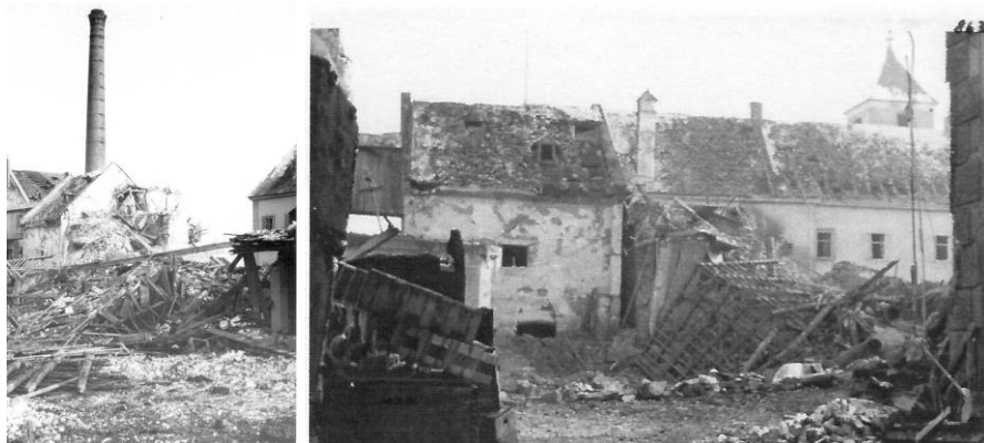
Abb.18,19: Totalschaden in der Mälzerei (links), Hof der Mälzerei, Dachschäden (rechts). 83
