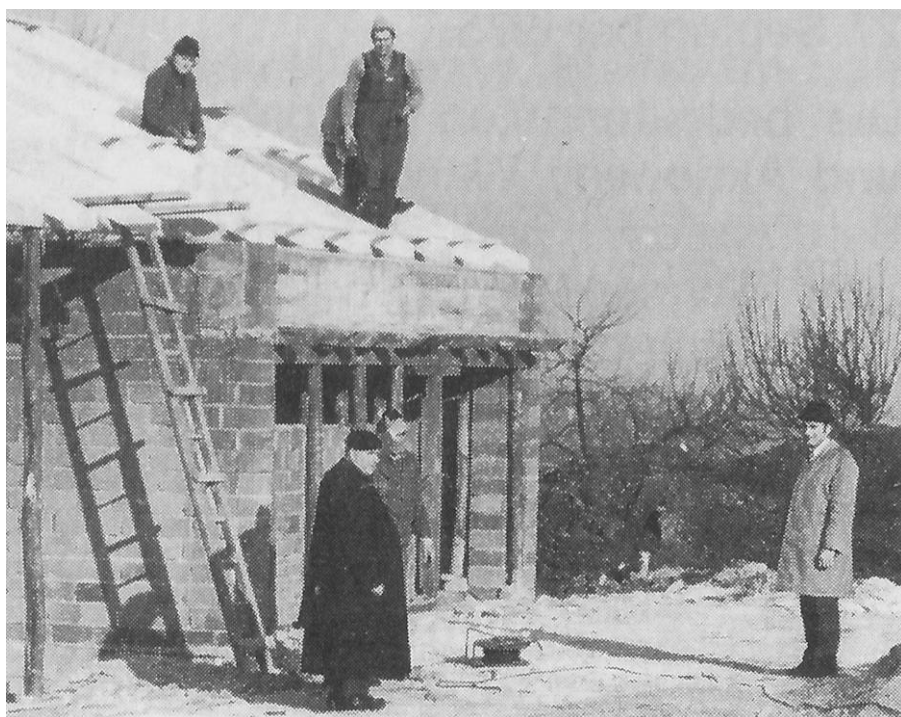
Abb.20: Bau des Kindergartens (um 1973). 86
