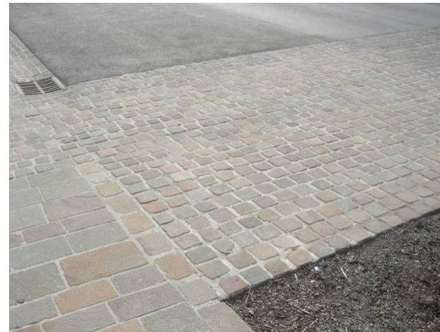
Abb.57: Die "Pflasterterpiche" in Pfarrkirchen bei Bad Hall werden gleich wie in Feldkirchen bei Graz im Netzverband angeordnet. Bild von 2013. 413
