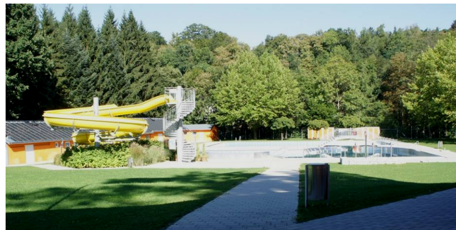
Abb.67: Freibad nach der Renovierung, 2012. 238
