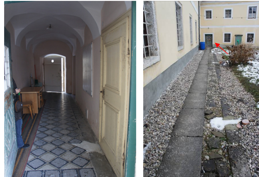
Abb.65: Dieser Durchgang wird in Zukunft offen sein. So entsteht eine attraktive Abkürzung zwischen Kirche und Pfarrhof. Blick vom Pfarrhofsgarten aus. Bilder von 2013. 330
