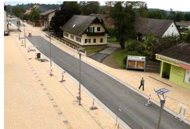
Abb.22: Shared Space in Gleinstätten. Die Asphaltstraße wird immer wieder durch Pflasterterpiche unterbrochen. 378
