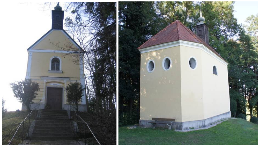
Abb. 65,66: Eingangsbereich der Kleinadlwangkirche, 2008 (links). 230 Rückseite, 2012 (rechts). 231
