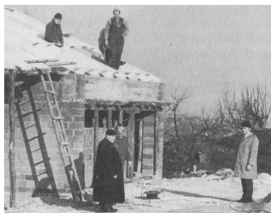
Abb.37: Bau des Kindergartens 1972/73. 188
