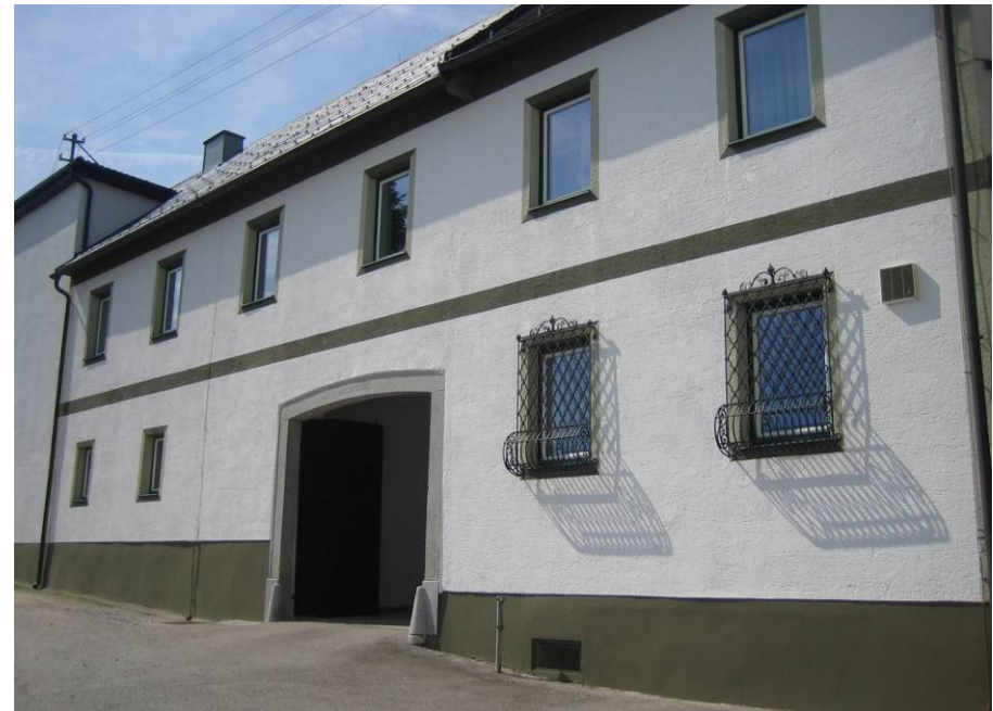
Abb.07: Einfahrt in den Innenhof, 2012. 264
