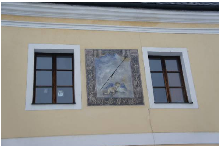
Abb.05: Sonnenuhr an der Fassade, um 1750. Bild von 2013. 299
