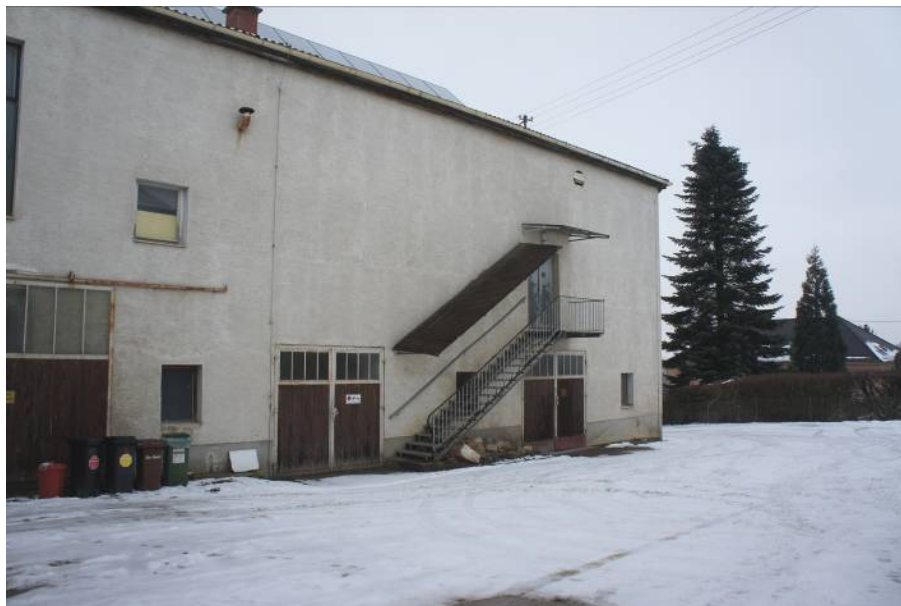
Abb.23a: Einstellbereiche von außen, und Nottreppe des Kinos. 280
