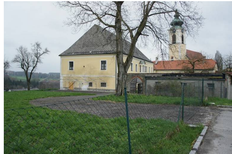
Abb.28: Neue Zufahrt zum Pfarrhof wurde Ende 2012 angelegt. Bild von 2013. 316
