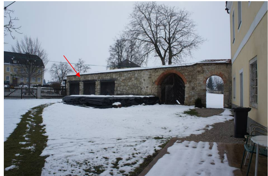
Abb.95: Anstelle der drei als Lagerfläche genutzten Garagen wird eine zweite Plattform entworfen. Bild von 2013. 437
