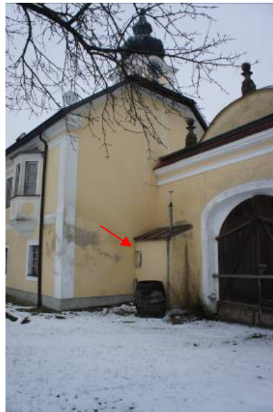
Abb.56: Die Toilette der neuen Pfarrkanzlei wurde nachträglich angefügt. 326
