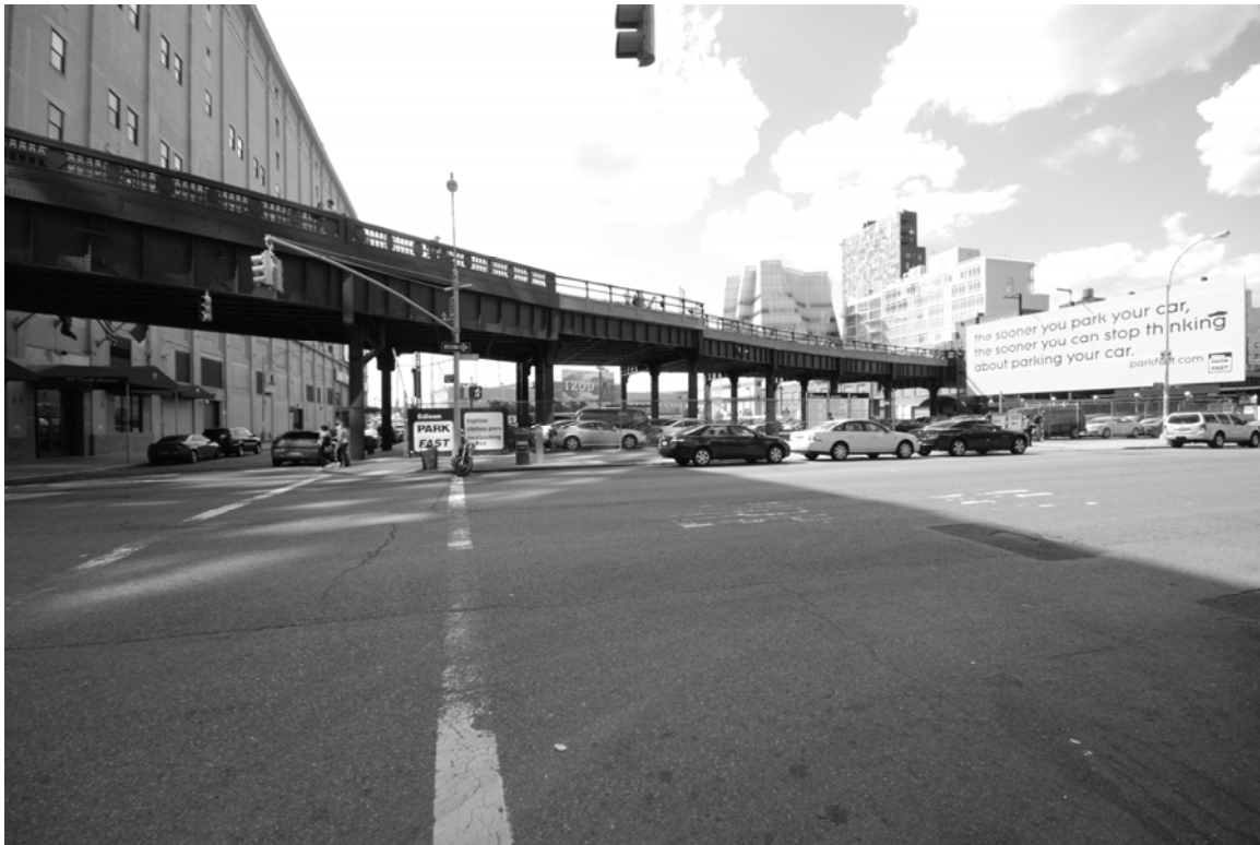
Blick von der 10th ave in Westrichtung (streetlevel).
