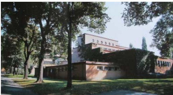
Abb. 18: Gesamtansicht der ehemaligen Zentralwäscherei im Karl-Marx-Hof
