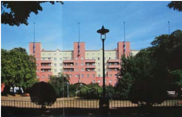
Abb. 16: Hauptfassade des Karl-Marx-Hofs
