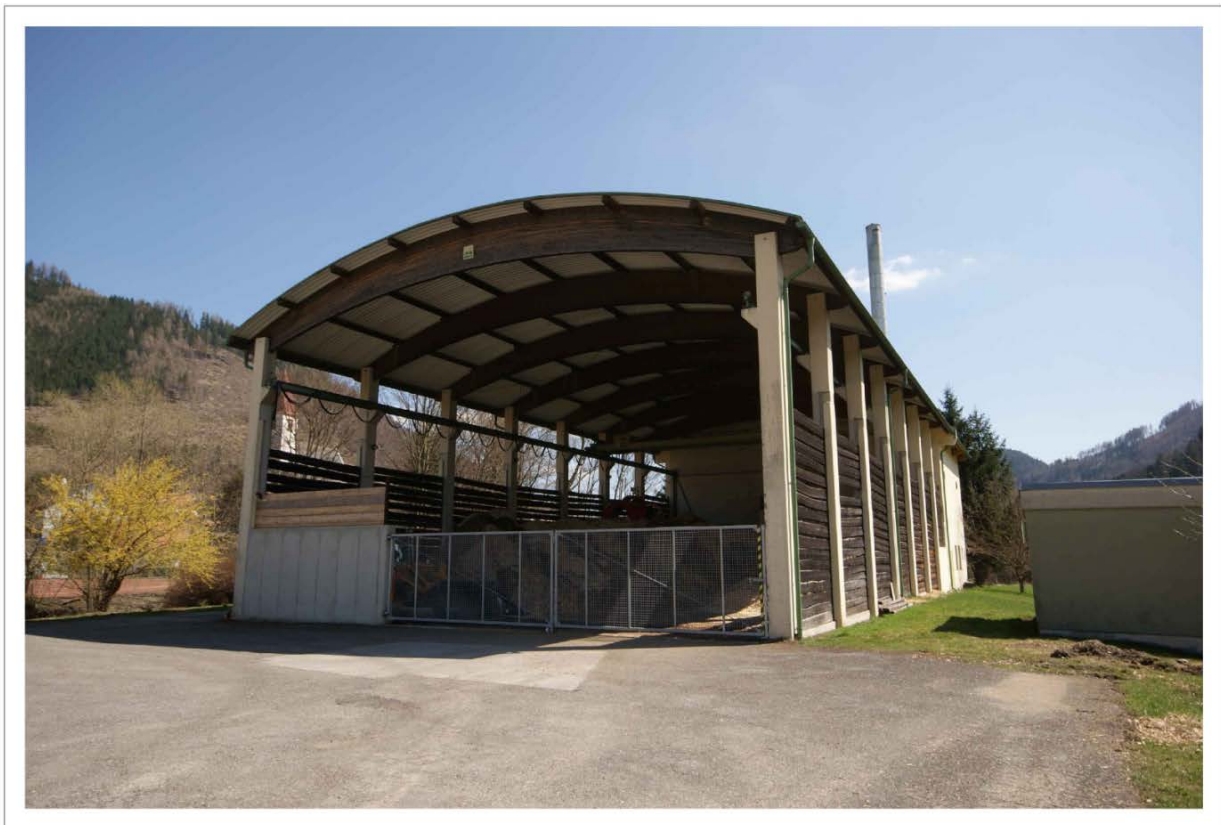
Abb.62: KELAG-Biomasseanlage in Übelbach, eigene Aufnahme
