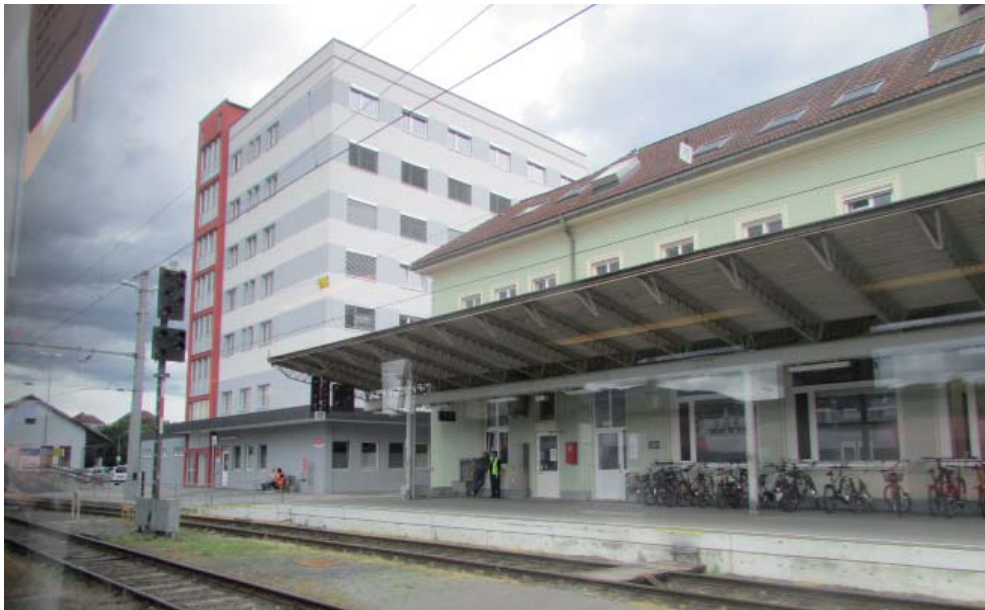
Abb.28: Nordansicht BahnBistro und Bahnsteig 1
