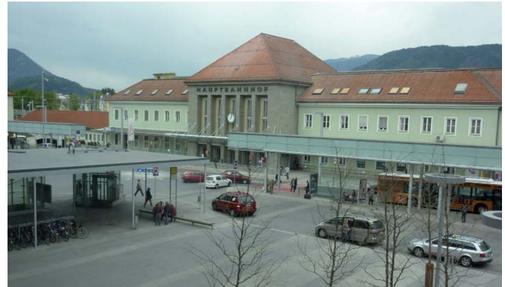
Abb.29: Blick auf den östlichen Vorplatz
