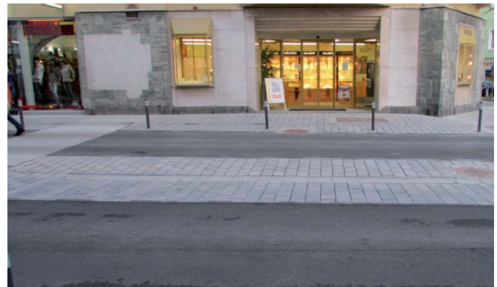
Abb.23: Das vollendete Shared-Space-Projekt, 2012, Zonierung durch Verwendung verschiedenster Bodenmaterialien
