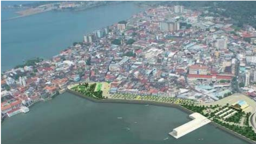
Abb. 155: Erweiterung der Cinta Costera (in Bau) [36] [37]
