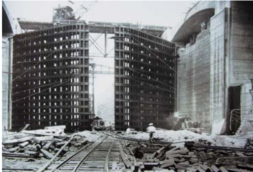
Abb. 32: Bau der Schleusen des Panamakanals [19]
