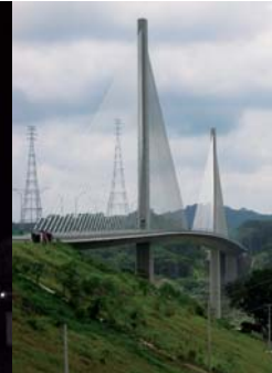
Abb. 39: Puente del Centenario
