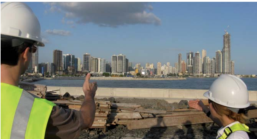
Abb. 53: Baustelle der Cinta Costera mit Blick auf die Skyline von Panama City
