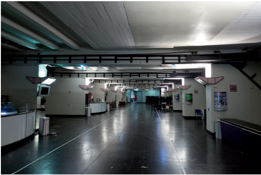
Abb. 29. Verteilergänge, Halle D, Erdgeschoß
