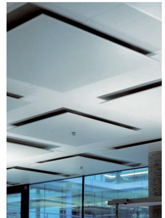
Die einzelnen quadratischen Module sind ca. 120/120cm groß. Die Zwischenräume werden mit einem 60/120cm großen flächigem Lichtelement bestückt. Dadurch ergeben sich im Innenraum umlaufende Deckenbänder, welche die eigentlich Technik gut verstecken. Anbindungen an den Kern werden ebenfalls überdeckt, sodass keine freien Leitungen den Innenraum beeinflussen.
