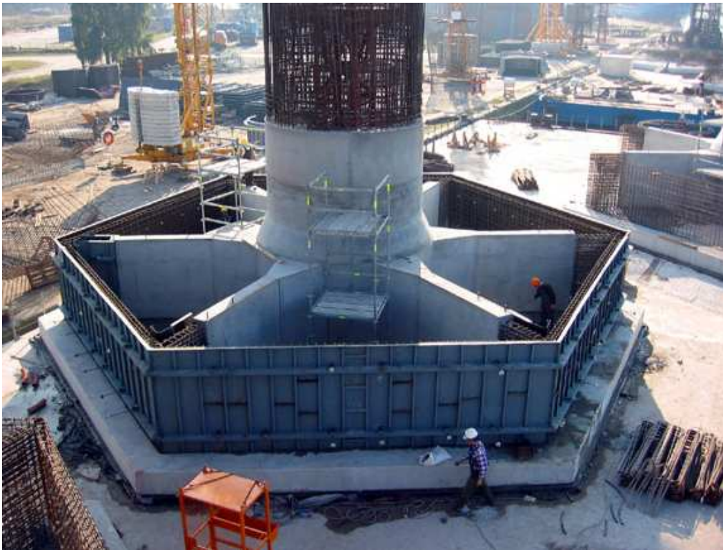
Abbildung 4.25 Schwerkrafftamentbau an Land [4.25]
