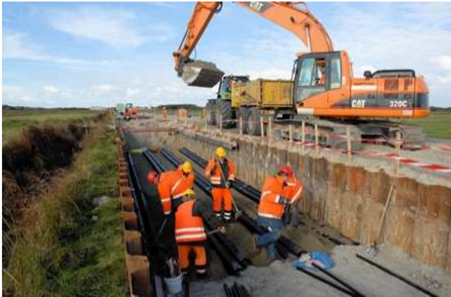
Abbildung 4.40 Kabelbauarbeiten auf der Insel [4.40]
