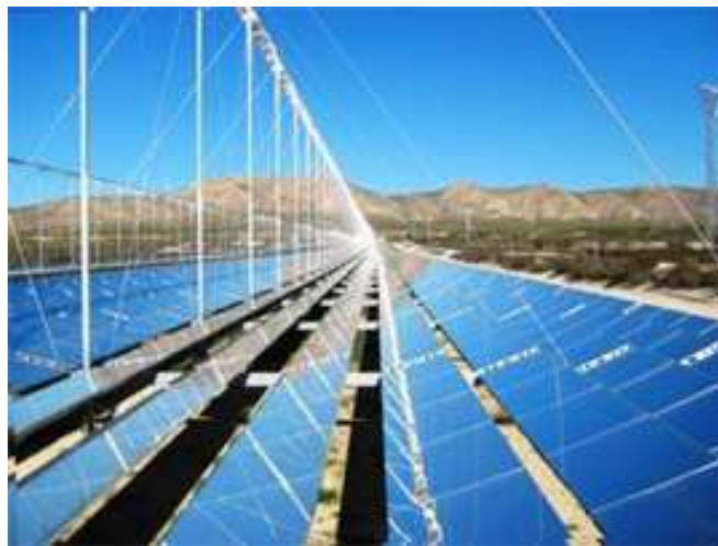
Abbildung 3.12 Fresnel-Kollektorfeld eines CSP in Calasparra Spanien [3.12]
