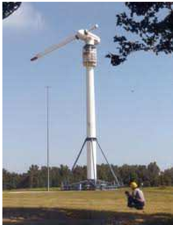
Abbildung 4.7 Einblattrotor [4.7]
